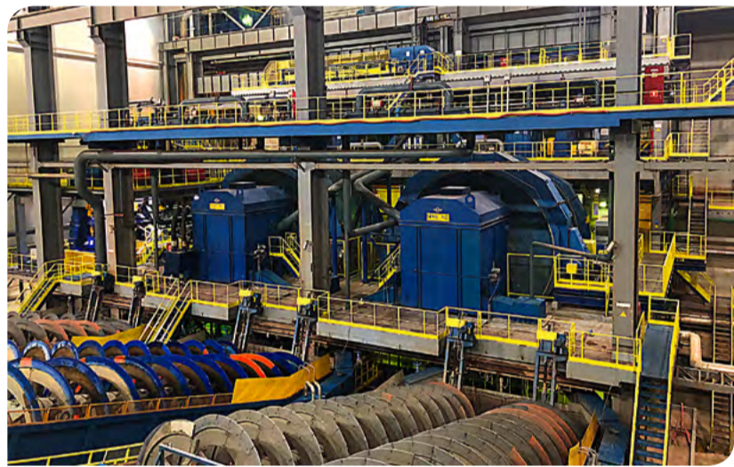
Общий вид участка рудоподготовки Обоганительной фабрики
